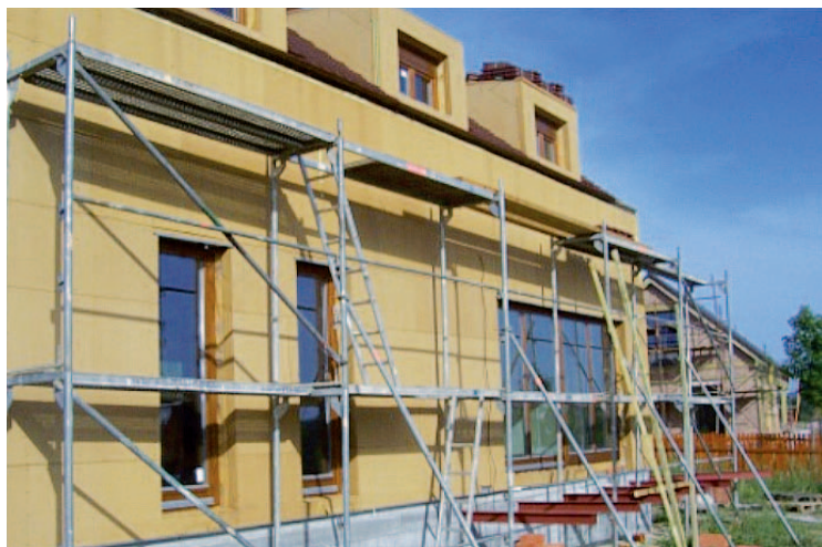
Obr. 5 Ukázka zateplení střešního a obvodového pláště v systému diffuwall®. Experimentální ověřování difuzně otevřené sestavy v klimatické komoře, CSI Praha
