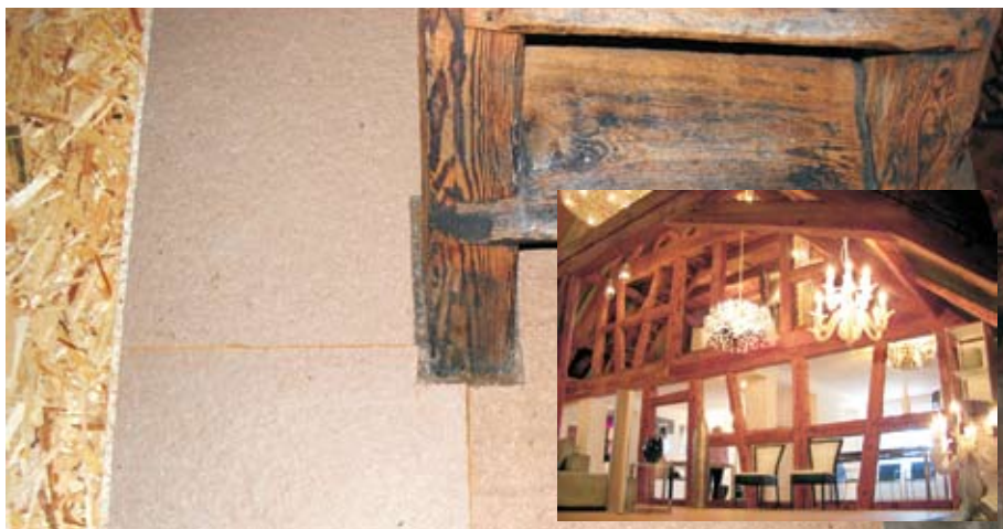
Sanácia starej drevenej podlahy s Hofafloor a OSB - roznášacia doska.
